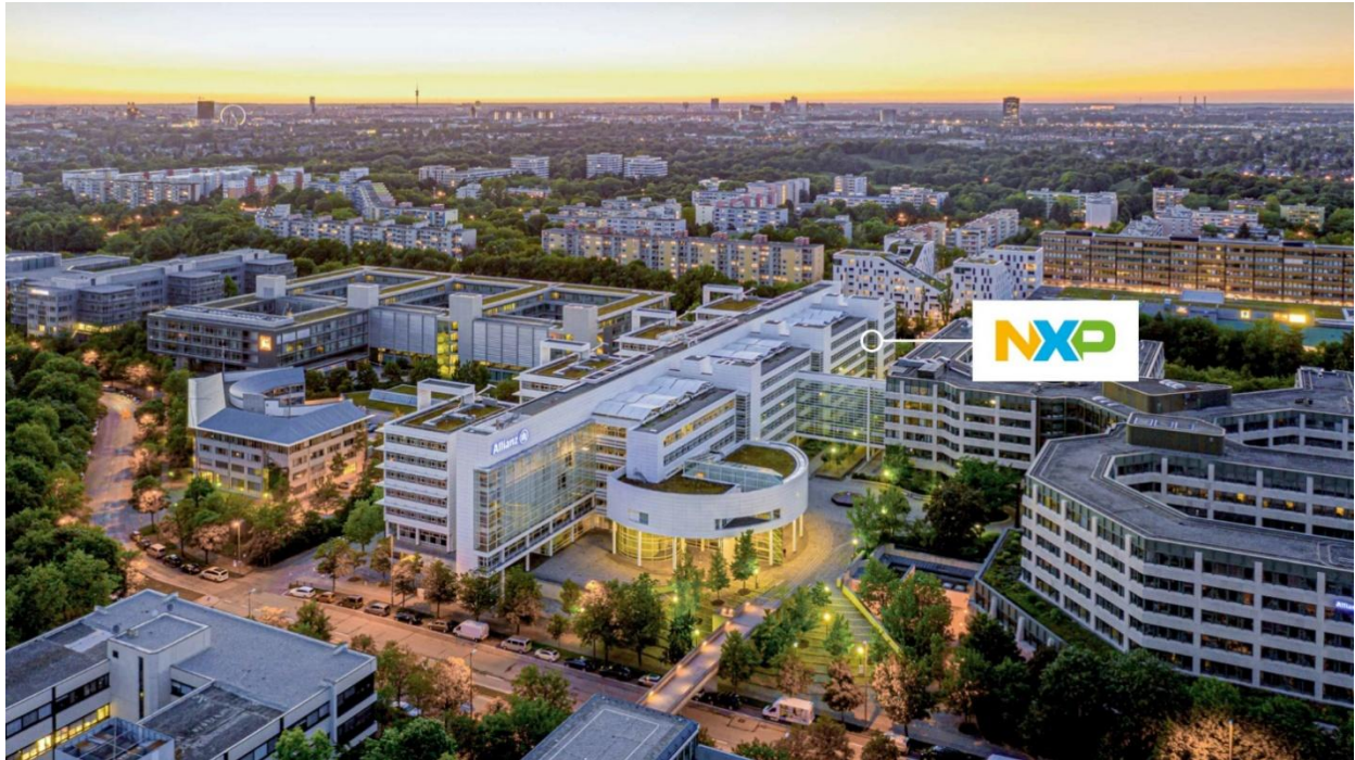
Blick auf das AER in München-Neuperlach, in dem NXP künftig neue Büroflächen beziehen wird.
